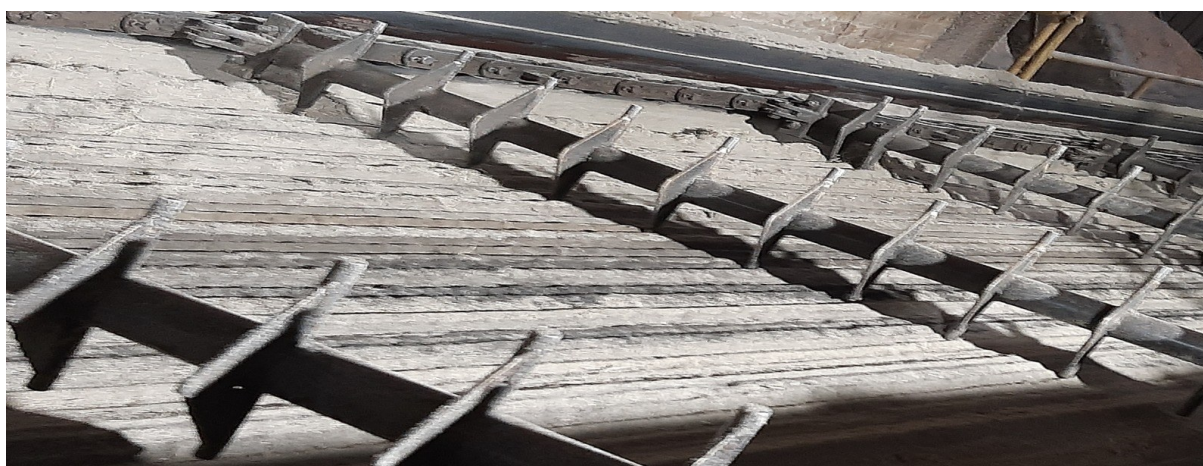
Figura 11. Baraja reforzada instalada en el conductor horizontal. Se observa la integración con la cadena y la repetición de aletas a lo largo del conjunto.
