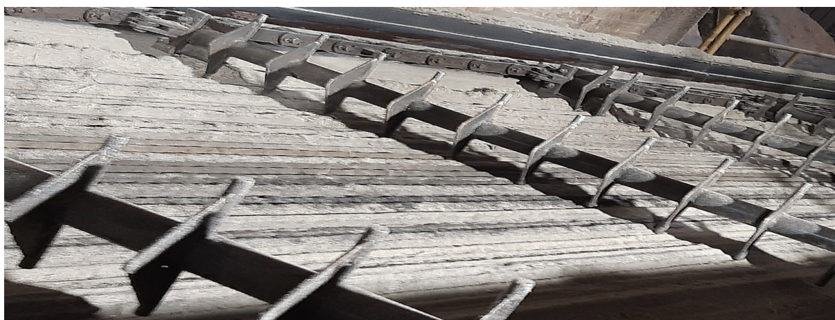
Figura 15. Baraja instalada en el conductor horizontal.
